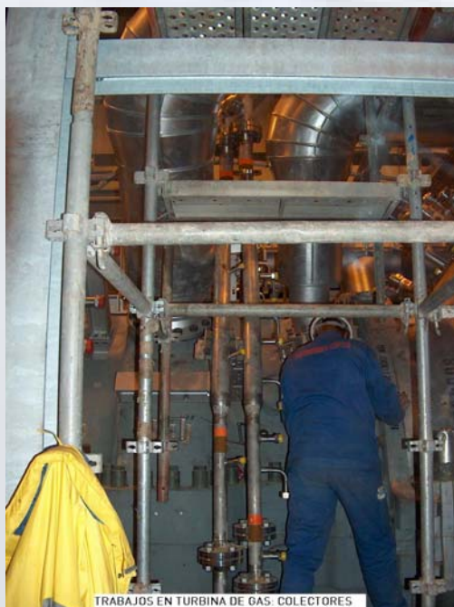
TRABAJOS EN TURBINA DE GAS. COLECTORES
