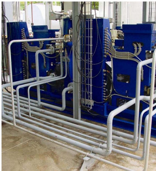
Planta de tri-cogeneración de energía para garantizar el suministro eléctrico a un grupo hotelero.
